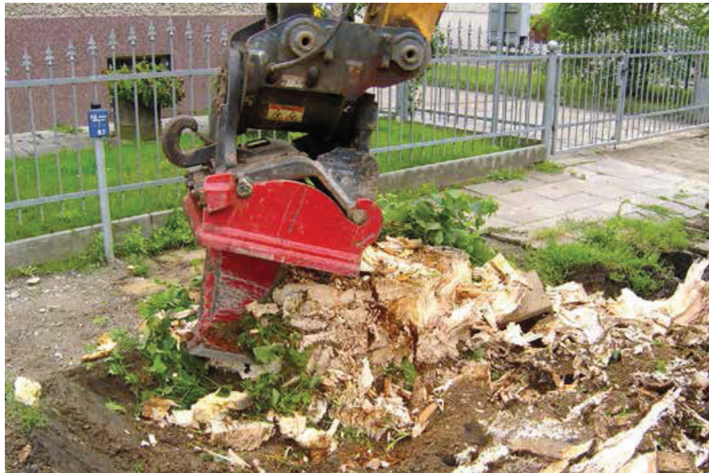
Arbeiten mit der Wurzelratte dicht an Gas- und Wasserleitungen sind kein Problem. (Foto: Wurotec)
