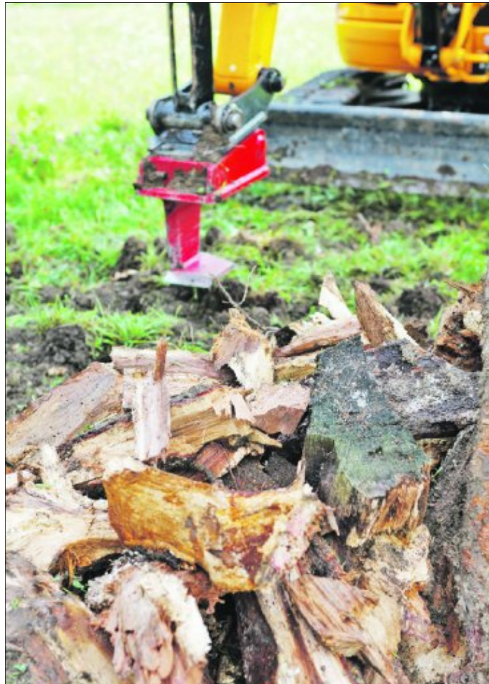
Die Wurzelratte im Einsatz.
