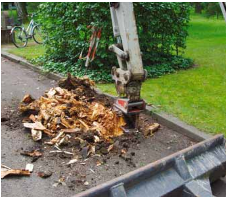
Erde und Holz bleiben getrennt: Es entsteht keine teuer zu entsorgende Holz-Humus-Mischung!
