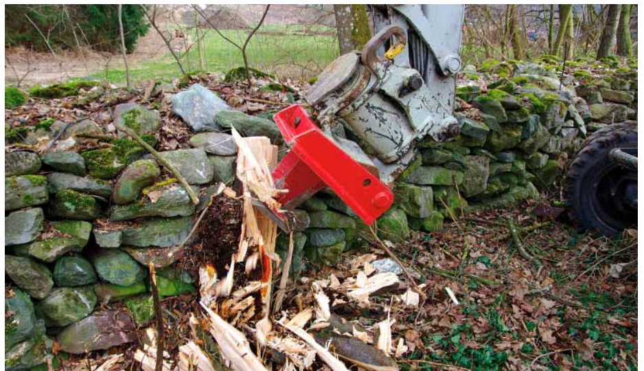
Rodung an einer lose aufgesetzten Steinmauer: Mit der L-Form der Wurzelratte lässt sich der Wurzelstock auch hier präzise und kontrolliert ausschneiden. | Fotos: Wurotec
