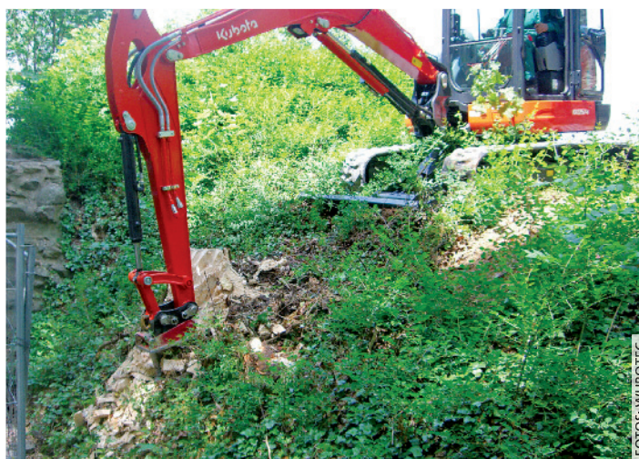
Wurzelstöcke können mit einem kleineren Bagger von oben her entfernt werden
