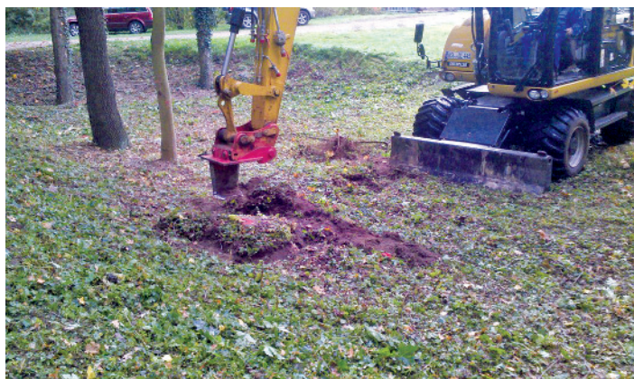
Auch Mobilbagger werden häufig mit der Wurzelratte eingesetzt
